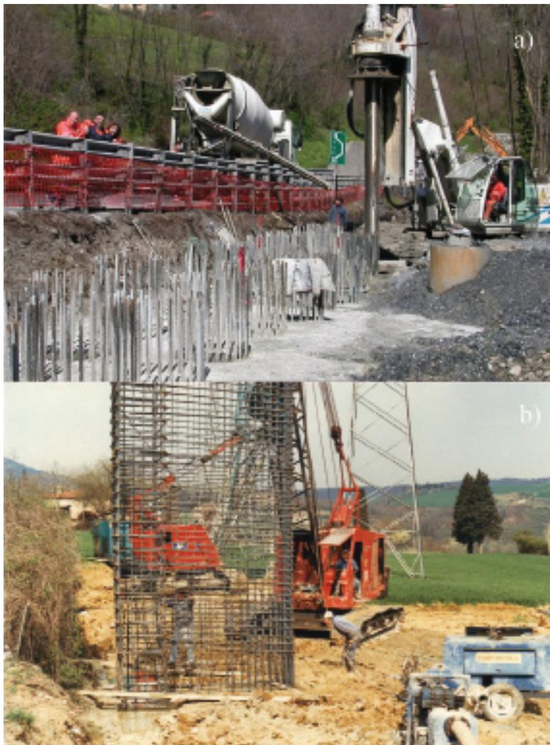
Figura 3. Fasi costruttive di un pozzo strutturale di grande diametro (fonte: *Studio Geotecnico Italiano*, in AA.VV., 2012).
