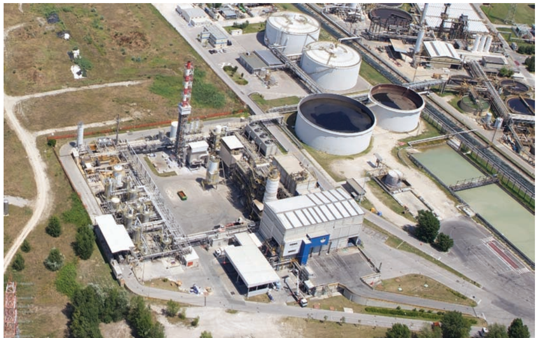
Figura 4. Vista area del comparto di Ravenna di via Baiona: impianto di termovalorizzazione di rifiuti pericolosi denominato F3, trattamento acque reflue industriali, combustione sfati.
